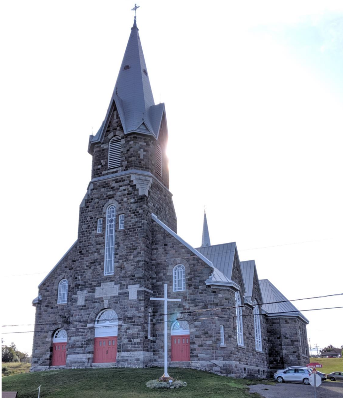
Photo 1 - Église de Baie-des-Sables - Vue générale
