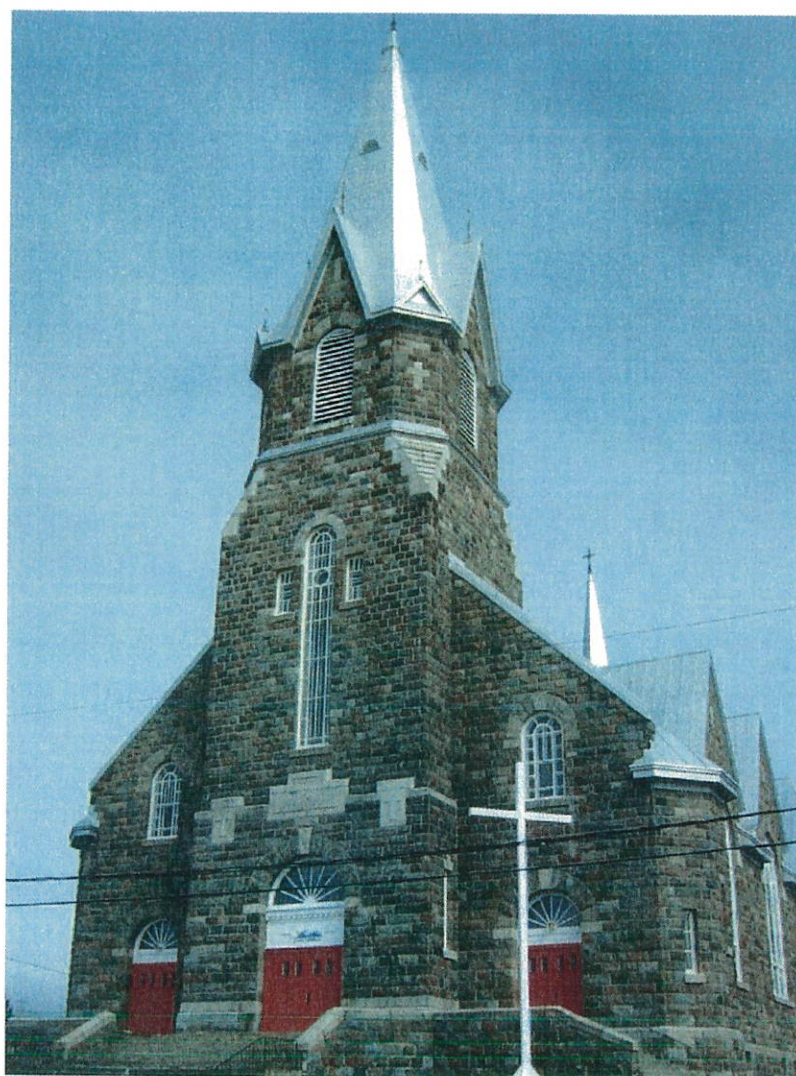
Photo 1 : Église de Baie-des-Sables - Vue générale
