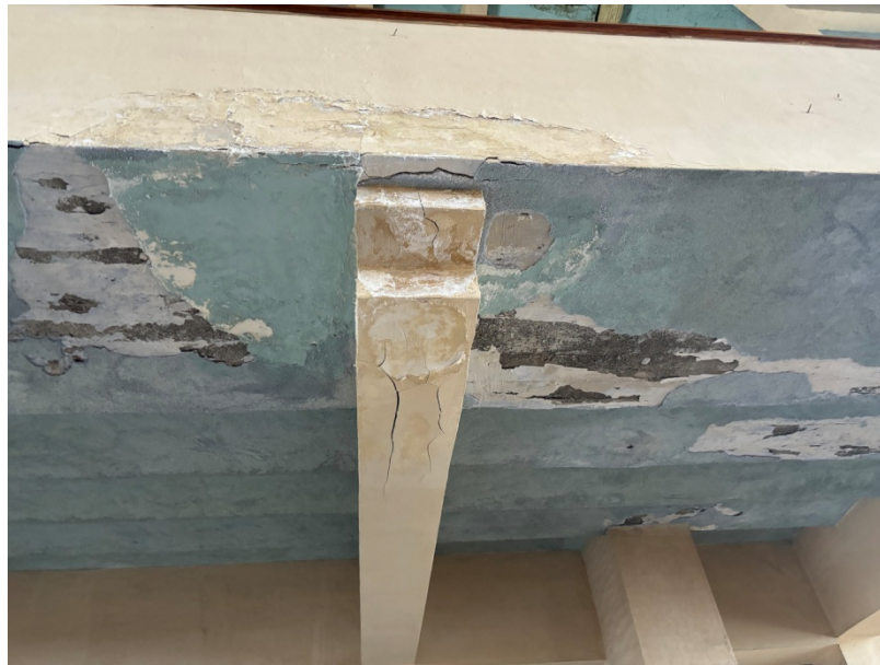
Figure 6 : Poutre en porte-à-faux du jubé
