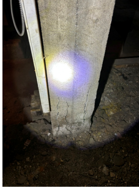
Figure 1 : Base d'une colonne désagrégée
